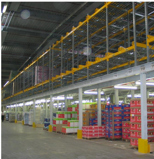
Stahlbaubühne mit Palettendurchlaufregal
